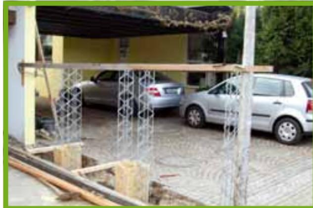
Wandsäulen ausrichten und Beton aushärten lassen.
